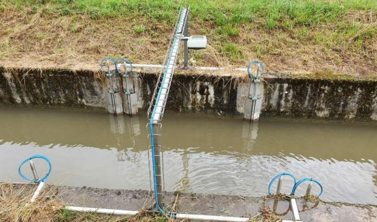
Medición de caudal con NivuFlow 650 en el antiguo molino de Friesen (canal con paredes verticales)
