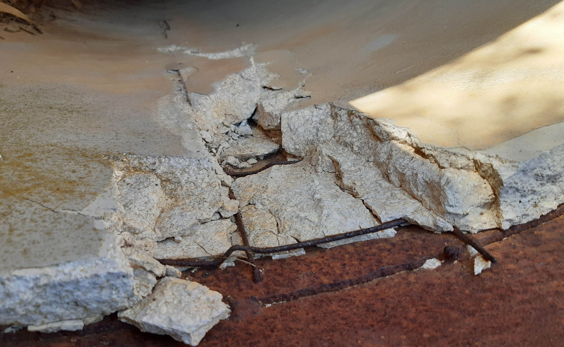
Foto: Detalle del espesor, da una idea de la complejidad que tendrá la medición
